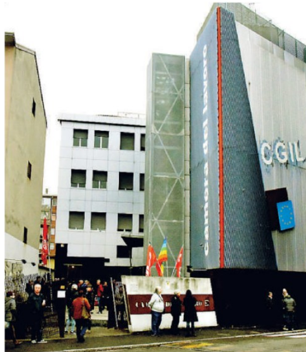
La sede piacentina della Camera del Lavoro di via XXIV Maggio
